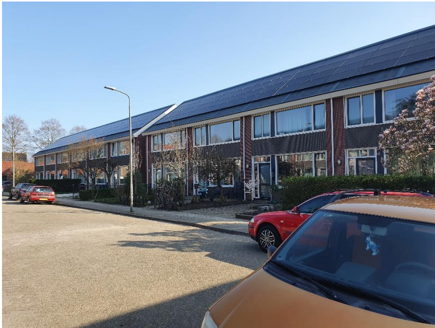
Afbeelding 1.6: Geplaatste zonnepanelen door Habeko wonen
